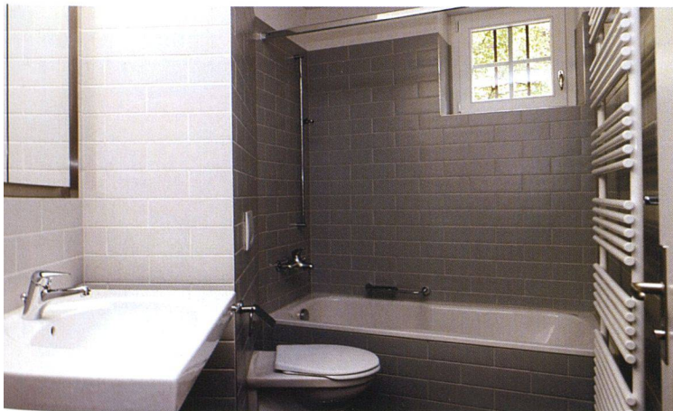
Auch die Bäder und die gesamten Installationen wurden erneuert.
