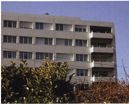
Viele Bieler Genossenschaften haben zuletzt in den 1960ern gebaut (Siedlung Gotthelfstrasse in Nidau der Eisenbahner-Baugenossenschaft).
