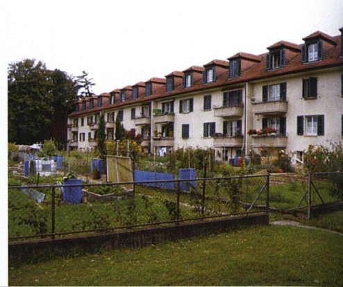
Der Architekt Eduard Lanz prägte das frühe genossenschaftliche Bauen in Biel. Seine Siedlungen waren stark von der Gartenstadt-Idee geprägt. Im Bild die Siedlung Rennweg in Mett von 1926 (Eisenbahner-Baugenossenschaft).
