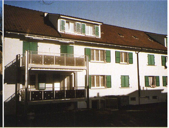
Die Sanierung der Nachkriegsbauten ist auch in Biel ein wichtiges Thema. Die Baugenossenschaft Im Vogelsang nutzte die Aussenrenovation, um die Häuser an der Mettstrasse mit Balkonen zu ergänzen (vorher – nachher).
