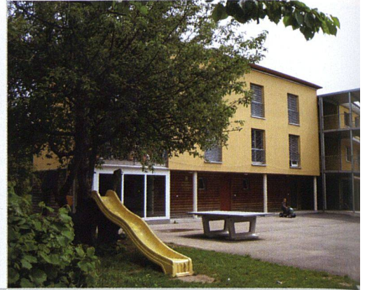
In den letzten Jahren entstanden in Biel kaum noch genossenschaftliche Neubauten. Eine Ausnahme bildet die Siedlung der Wogeno Biel von 1998.
