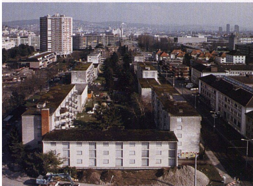
Das Werden eines Ersatzneubaus. Die rund 40-jährigen Bauten an der Bernerstrasse wurden abgebrochen, nun wächst die Neubausiedlung Werdwies heran.
