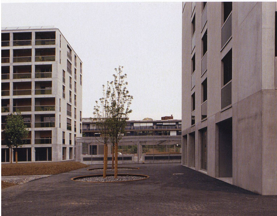
Zwei der sieben achtgeschossigen Bauten mit insgesamt 152 Wohnungen sind fertig.
