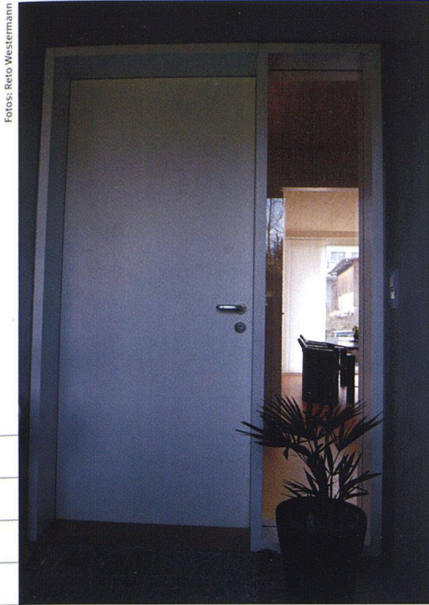
Teil des Kommunikationskonzepts: Schmale Fenster neben den Eingangstüren ermöglichen den Blick in Nachbars Wohnung.
