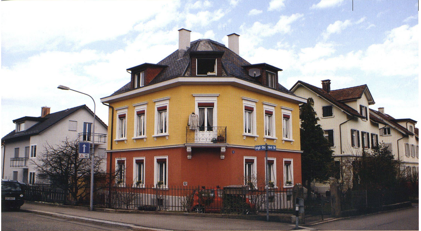
Das über hundert Jahre alte Haus an der Hürststrasse in Zürich Affoltern wird etappenweise renoviert.
