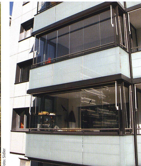
Die Wintergärten in dieser Siedlung der Baugenossenschaft Glattal lassen sich mittels Schiebelementen öffnen.
