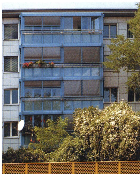
Die Lärmbelastung entlang der Stadtautobahn in Schwamendingen ist durch die Schallschutzverglasung der Balkone deutlich gesunken.
