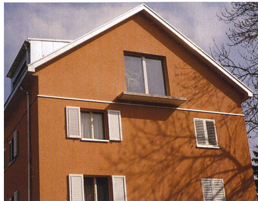
Der alte Dachstock wurde durch eine Konstruktion aus vorgefertigten Holzbauelementen ersetzt. Auf den Stirnseiten verleihen französische Balkone den Wohnungen viel Licht.
