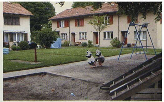
Am Kronwiesenweg werden wieder Reihenhäuser entstehen.
