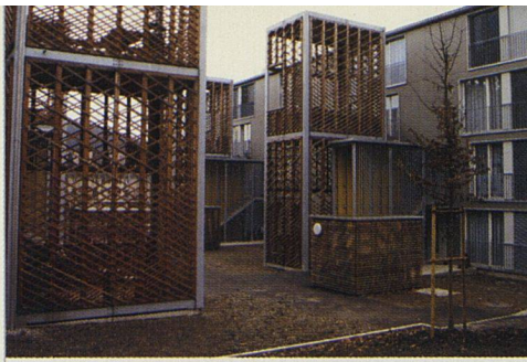
Gelungener Ersatzneubau der Vitasana: die gestapelten Reihenhäuser am Burriweg.
