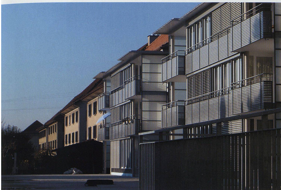
Auf der Südseite baute man eine zwei Meter breite Schicht an, dank der das Wohnzimmer vergrössert und neue Balkone erstellt werden konnten. Im Vordergrund der Betondeckel der Tiefgarage. Rechts oben: Blick auf den neuen Balkon.
