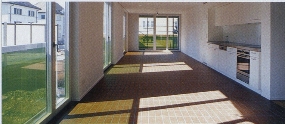
Praktisch unverwüster Klinker kommt bei der Neubausiedlung Werdwies der Stadt Zürich zum Einsatz. Bei diesem früher häufig verwendeten Belag handelt es sich um einen besonders stark gebrannten Backstein.
