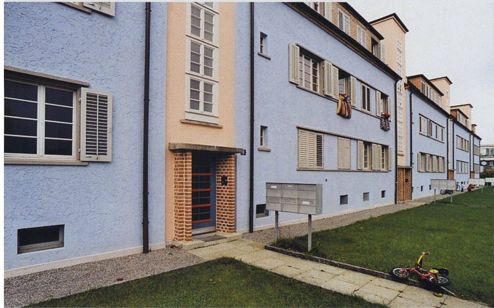
Blick von der Eingangsseite: Zeittypisches der 1920er-Jahre sichtbar gemacht.
