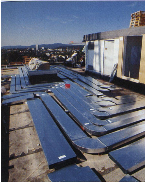
Die Belüftung der Wohnungen geschieht über die Fassade: Auf dem Dach befindet sich die Anlage zur Wärmerückgewinnung.
