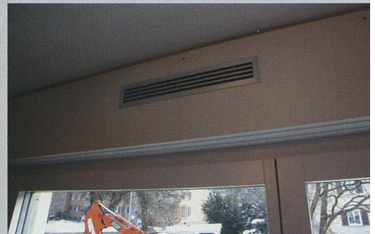
... das die frische Luft über den Fenstern in die Wohnräume leitet.
