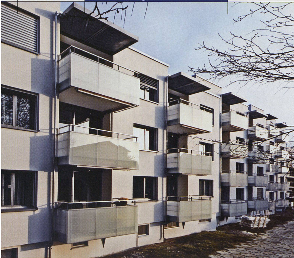
Auch die stützenlose neue Balkonkonstruktion respektiert das ursprüngliche Erscheinungsbild.
