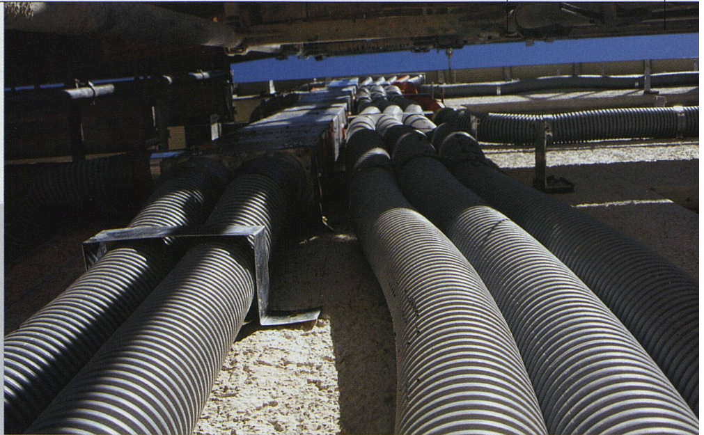
Die Rohre verlaufen in der – hier noch fehlenden – Isolierungsschicht den Fassaden entlang ...
