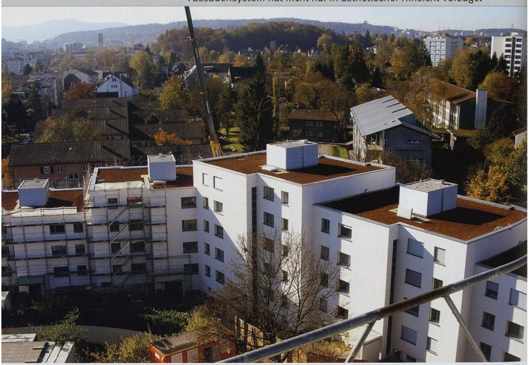
Einer der zwei abgestuften Blöcke der ASIG-Siedlung Mattacker in Zürich Seebach kurz vor Vollendung. Die Genossenschaft entschied sich bei dieser Sanierung für eine hinterlüftete Fassade, die verputzt werden kann.
