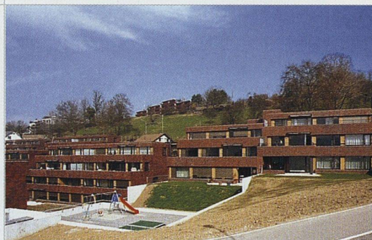
Um seinen Wohnungsbestand zu verjüngen, war das Unternehmen in den letzten Jahren auch selbst im Neubau aktiv. Ein Beispiel dafür ist diese vom Zürcher Architekten Jakob Steib entworfene Wohnsiedlung in Wettswil ZH.
