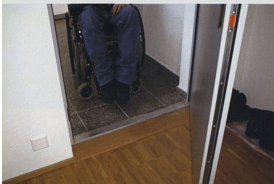
Die Überbauung Ursprung in Münchenbuchsee wurde hindernisfrei anpassbar gebaut. Dazu gehören auch Einrichtungen, die allen Bewohnern zugute kommen und deshalb Standard sind, etwa ein schwellenloser Wohnungseingang, ein Lift oder eine Garagenrampe.
