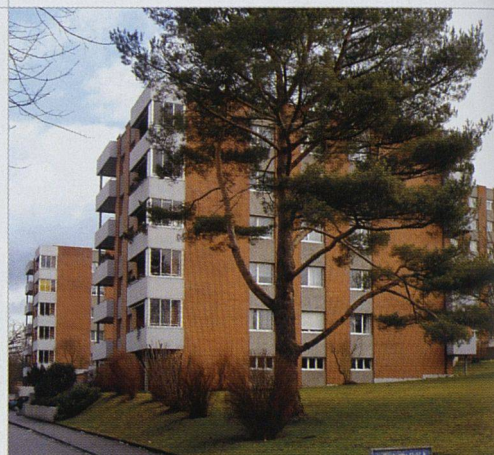
Die Siedlung Meiriacker liegt in parkähnlicher Umgebung an bevorzugter Lage in Binningen BL.
