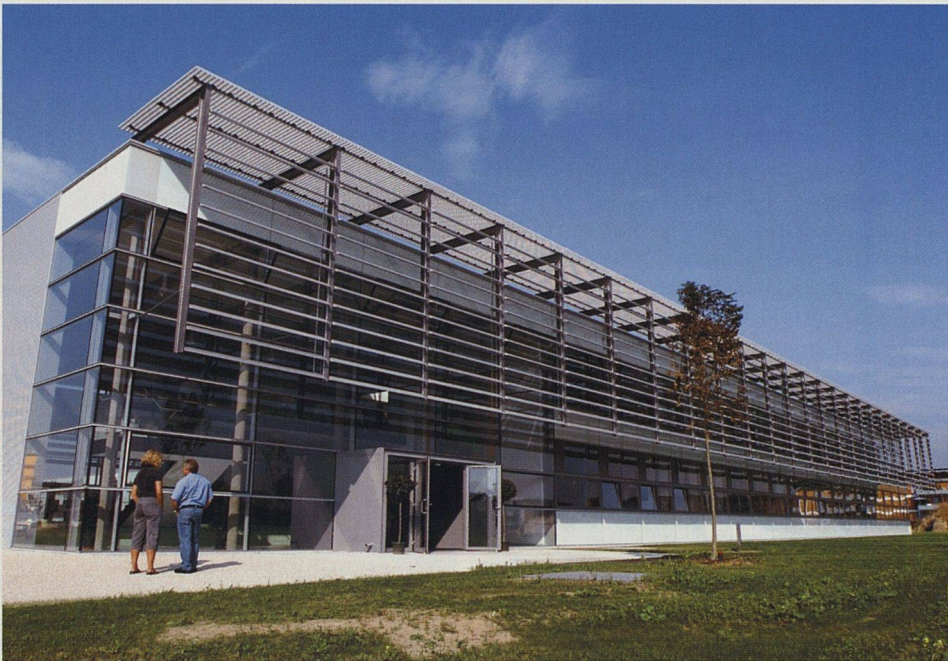
Das Schulgebäude, entworfen vom Wiener Architekten Michael Loudon, nutzt die Sonne dank hohem Glasanteil besonders intensiv. An den Längsfassaden war deshalb ein Sonnenschutz notwendig. Er befindet sich zwei Meter vor dem Gebäude, sodass bei geschlossenen Lamellen immer noch Licht ins Gebäude fällt.
