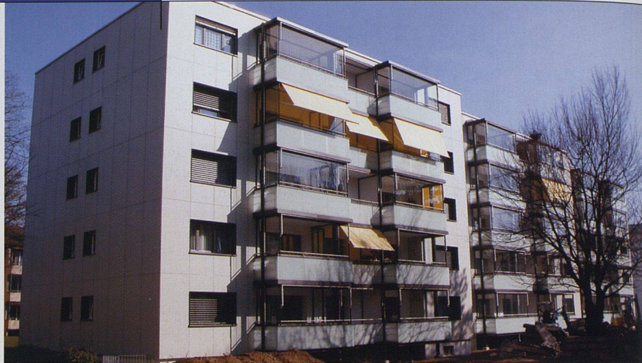
Die Bauten waren im Flügelbereich bisher nur viergeschossig (links, früherer Zustand). Dank der Aufstockung auf durchwegs fünf Stockwerke entstanden acht neue Wohnungen. Vergrösserte, verglaste Balkone sorgen für mehr Wohnkomfort.
