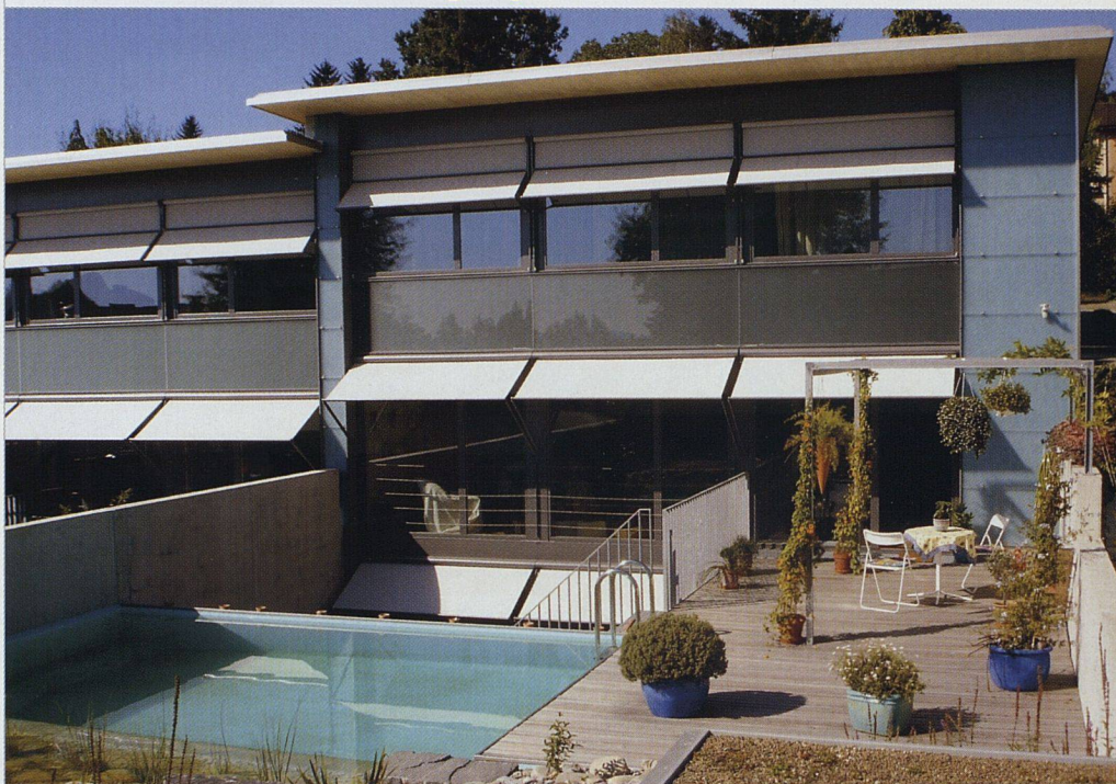
Im strengen Öko-Rating der Alternativen Bank Schweiz erreicht das «SolarHausPlexus» des Winterthurer Architekten Giovanni Cerfada (Ecobauhaus AG) die höchste Rabattstufe. Im Bild die 2003 entstandene Siedlung Wasserfuristrasse in Wiesendangen ZH.
