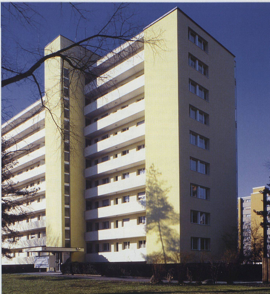
Das neungeschossige Gebäude liegt in der Flugschneise Süd – umso wichtiger sind günstige Mietzinse.
