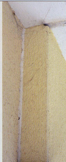
Während die ASIG in ihrem Gebäudeteil auch eine energetische Sanierung ausführen liess, verzichtete der private Nachbar-Eigentümer auf diese Massnahme.
