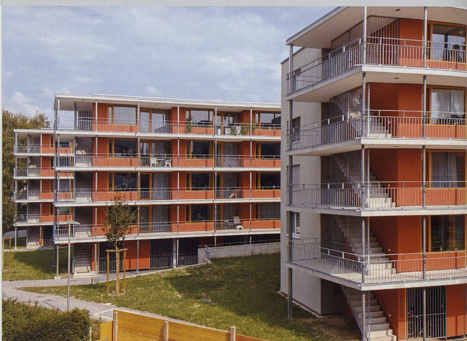
222 neue Studenten-zimmer sind in der Siedlung Bülachhof entstanden. Die Erschliessung erfolgt über Laubengänge, die gleichzeitig eine Balkonzone bilden und für Kommunikation sorgen sollen.
