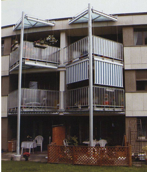
Für die 60er-Jahr-Siedlung der Baugenossenschaft Rotach in Rümlang erwiesen sich Balkonanbauten in Dreieckform nicht nur ästhetisch als gute Lösung: Die Wohnungen gewannen gar an Tageslicht.
