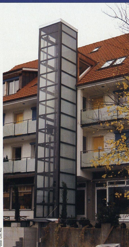
Foto: Lift AG
