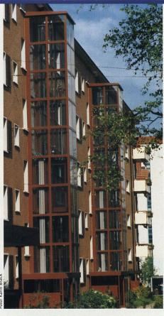
Die Baugenossenschaft Letten versah ihre Bauten an der Hohlstrasse 275 und 277 in Zürich mit Aussenliften. Wegen der bestehenden Treppenanlage mussten die Zugänge auf Zwischenpodesten angeordnet werden (Schindler AG).
