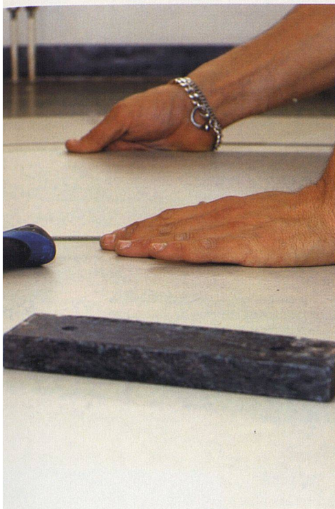
Zusammenklicken der Platten (Siedlung der Baugenossenschaft Milchbuck in Zürich Seebach).
