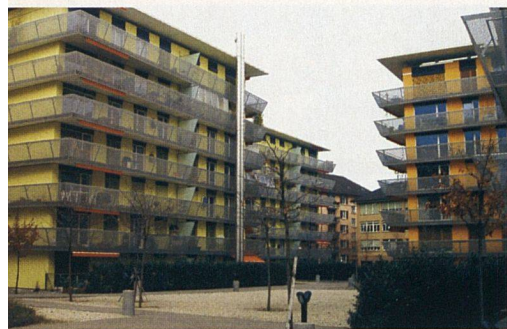
Für das Röntgen-Areal, an der Einfahrt zum Zürcher Hauptbahnhof gelegen, fanden die SBB lange keinen Investor. Erst Leopold Bachmann führte das Projekt des Architekturbüros Stürm und Wolf aus. Trotz Lärmimmissionen sind die zentral gelegenen, günstigen Wohnungen sehr beliebt.
