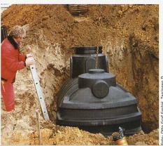
Aus hygienischen Gründen empfehlen Experten einen kugelförmigen Tank, der tief in der Erde vergraben wird.
