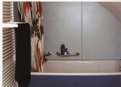
Die Badewanne ist so in die abgeschrägte Wand eingepasst, dass man auf einer Seite bequem einsteigen und duschen kann.
