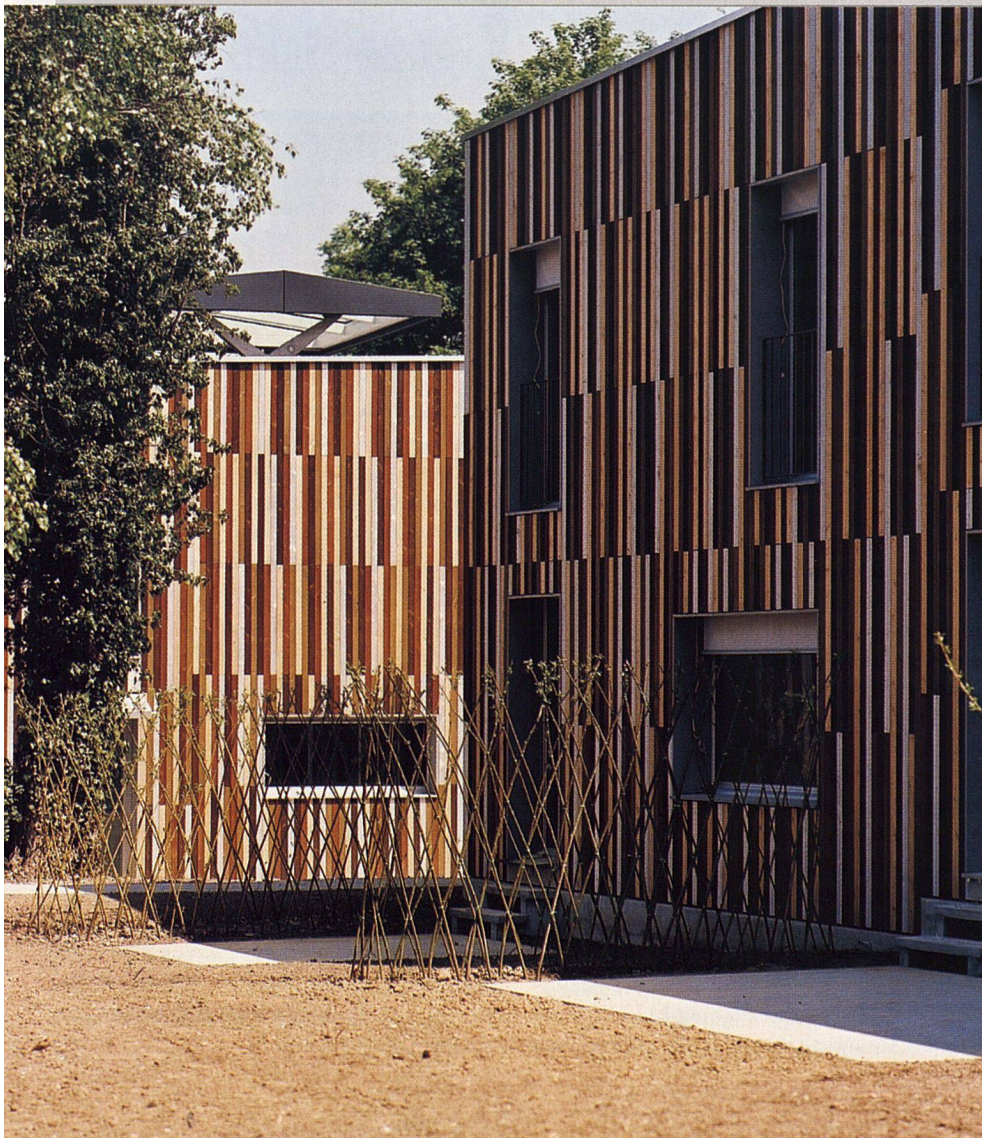
Siedlung RebGässli, Allschwil BL: Die auffallende Fassade steht im Kontrast zu einfachen Formen.
