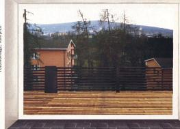
Balkonbrüstung mit Inhalt: 45 m² Vakuumkollektoren liefern Wärme für Heizung und Warmwasser.
