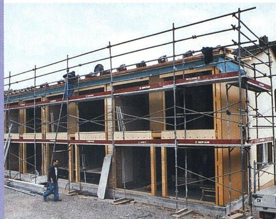
Die Häuschen der ersten Etappe Wehntalerstrasse 187-197 sind fertig saniert. Auf der Hofseite erweiterte man sie mit einem 2,2 Meter breiten Anbau. Die strassenseitigen Fassaden blieben dagegen unverändert.
