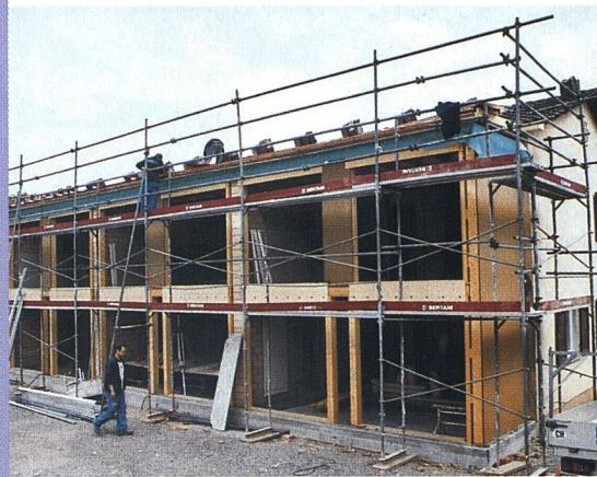
Die Häuschen der ersten Etappe Wehntalerstrasse 187-197 sind fertig saniert. Auf der Hofseite erweiterte man sie mit einem 2,2 Meter breiten Anbau. Die strassenseitigen Fassaden blieben dagegen unverändert.
