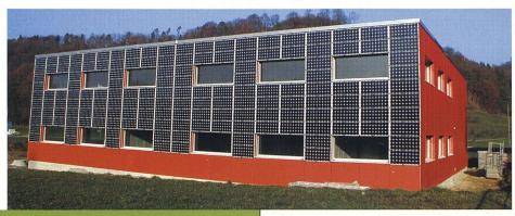
152 Solarmodule bilden die Südwestfassade des Wattwerks.
