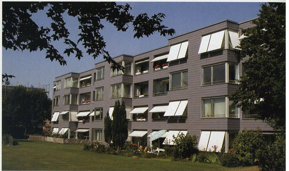
Eine besondere Knacknuss stellte die Sanierung der von Ernst Göhner in den 60er-Jahren erstellten Plattenbausiedlung Sunnebüel in Volketswil dar. Einerseits ging es darum, die 752 Wohnungen für die nächste Generation benutzbar zu machen. Andererseits mussten die Mietzinse bezahlbar bleiben. Im Bild eine Liegenschaft mit Erweiterungsanbauten.
