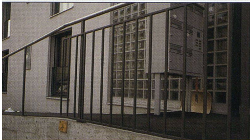
Die neue Siedlung erfüllt die Anforderungen an behindertengerechtes Bauen.
