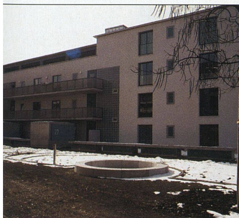
Die Gebäuderückseite mit dem Eingangsbereich. Verspieltes Detail: Glasbausteine streuen natürliches Licht in die Treppenhäuser.
