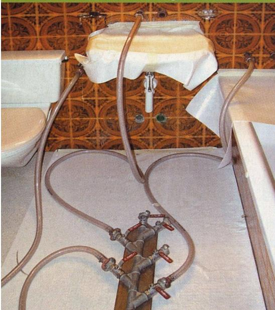
Die Rohr-Innensanierung mit dem bewährten LSE-System bietet sich als ausgereifte Lösung an – ohne Aufbrechen von Wänden und Böden. Seit über 15 Jahren wird das System weltweit erfolgreich eingesetzt. Tiefere Kosten und kürzere Sanierungszeiten als mit herkömmlichen Sanierungsarten sind die Hauptargumente für das umweltschonende System. Sämtliche Räume bleiben während der ganzen Sanierung bewohn- und benutzbar.
