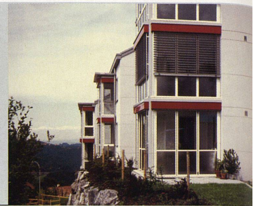
Die BewohnerInnen des neueren Siedlungsteils schätzen die grosszügigen verglasten Balkone, die 1996 zeitgleich mit der Fassadensanierung erstellt wurden.
