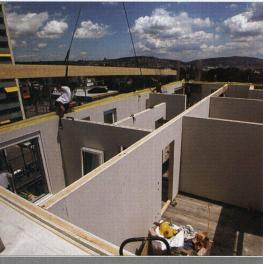
Bei allen An- und Neubauten setzten die Architekten auf vorgefertigte Holzelemente – so auch bei den Attikawohnungen.
