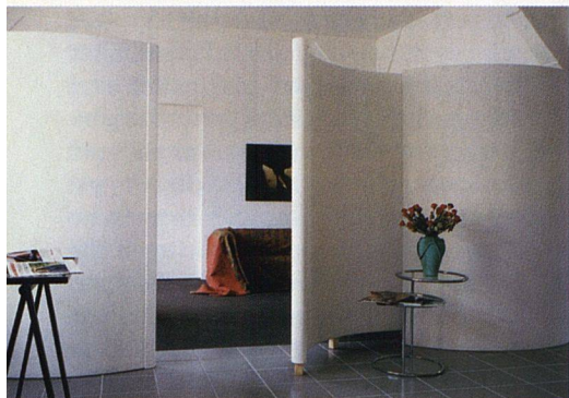
Gips-Bauplatten lassen sich vielseitig einsetzen, unter anderem auch für gerundete Wände.
