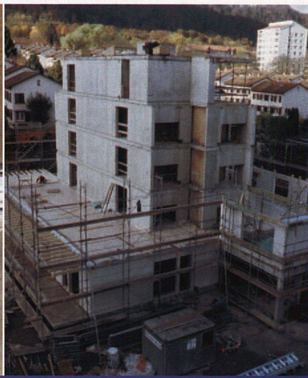
Die Siedlung Hegianwandweg während der Bauzeit. Der massive Kernbereich hebt sich vom Holzbau ab, wo die Wohnräume untergebracht sind. Die Struktur macht die freie Einteilung der Wohnungen möglich. Auf dem Bild rechts im Hintergrund FGZ-Reihenhausneubau.
