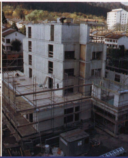
Die Siedlung Hegianwandweg während der Bauzeit. Der massive Kernbereich hebt sich vom Holzbau ab, wo die Wohnräume untergebracht sind. Die Struktur macht die freie Einteilung der Wohnungen möglich. Auf dem Bild rechts im Hintergrund FGZ-Reihenhausneubauten.
