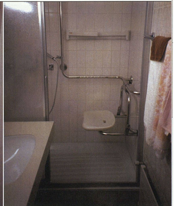
Der Ersatz der Badewanne durch eine Dusche mit Klappsitz ist eine sinnvolle Anpassung.
