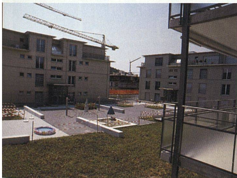
Blick in einen der beiden Innenhöfe.
