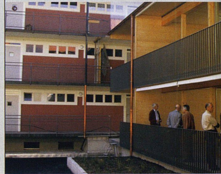
Blick vom Innenhof auf einen Holzzwischenbau und die Laubengänge.
