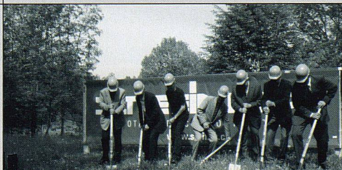
Baubeginn in Zürich-Witikon. 75 Wohnungen erstellen die Baugenossenschaften Asig und WSGZ gemeinsam.
