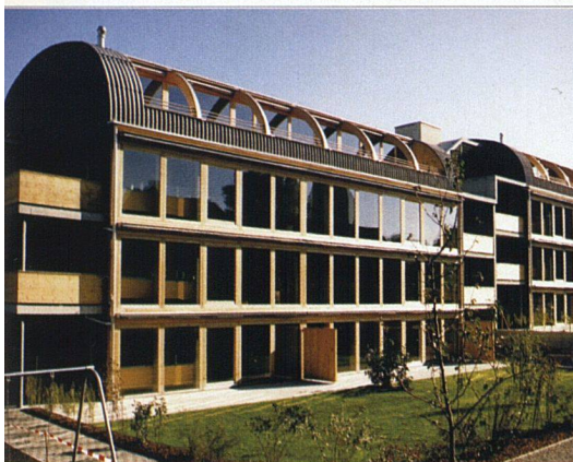
Bei der Siedlung Terra Nova in Stäfa sorgt eine hochgedämmte Fassade mit neuem Ankersystem für sehr tiefe Energieverbrauchswerte.
