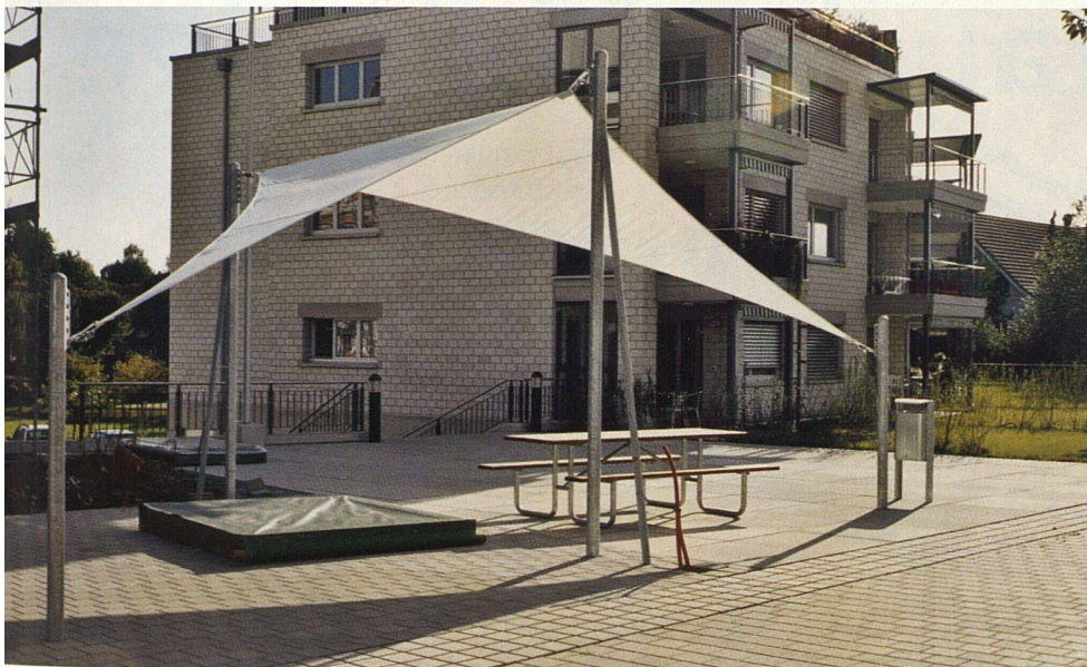
Frei stehendes Sonnensegel bei der Überbauung Spuhlacker, Tägerwil (Texblatech, Märstetten).
