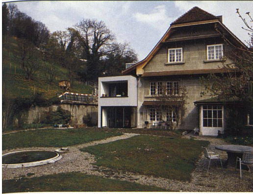
Blick vom Garten, links ist der neue Anbau ersichtlich. Er enthält Lift, Küchen und Nasszellen.
