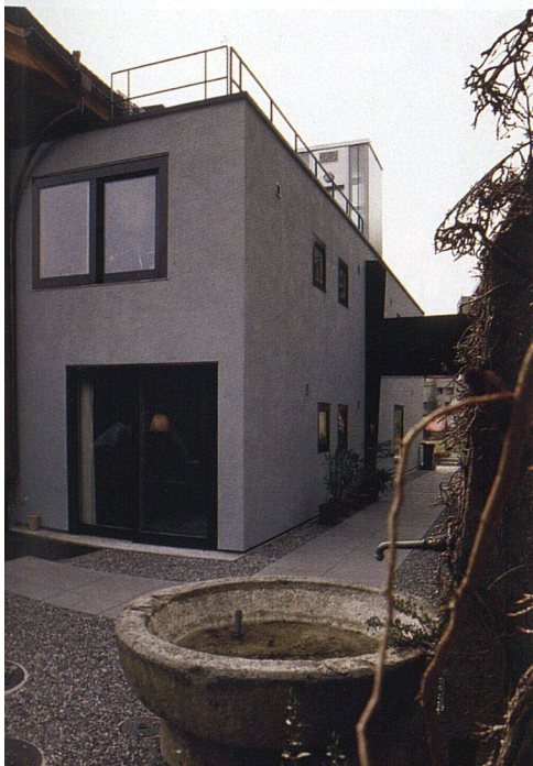
Der neue Anbau.
