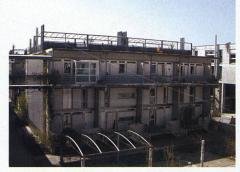
Die Fassaden auf der Schattseite bestehen aus verschiedenen kastenförmigen Holzverkleidungen und kleineren Fenstern – nicht zuletzt aus Energiespargründen.
