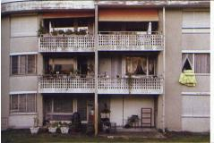
Gänzlich neues Bild: Die sanierte Liegenschaft mit der Fassadenverkleidung aus Eternit, den Balkonanbauten und neuem Dachbalkon.
