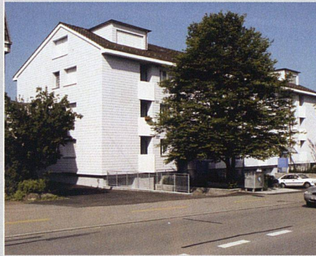
Auf der Strassenseite schützen Schallschutzfenster vor dem Lärm; gut erkennbar ist hier die Anordnung der Eternitplatten.
