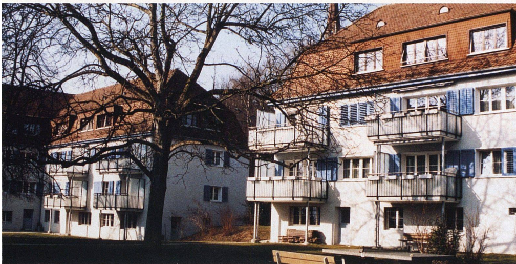
Denkmalpflegerisch gelungene Lösung bei den neuen Balkonen der Siedlung Geibel in Zürich-Wipkingen (Baugenossenschaft Waidberg): In einer statischen Mischkonstruktion sind sie an den Häusern aufgehängt und zusätzlich mit schlanken Pfeilern abgestützt
