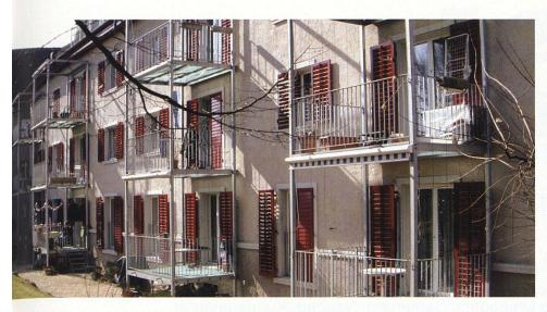
Auf eine Turmlösung setzt die Baugenossenschaft ZürichOberstrass: Dank der als Roste ausgebildeten Brüstungen, der Bodenplatten aus Milchglas und der seitlichen Stahlseile, wo dereinst Kletterpflanzen wachsen werden, kommen die neuen Konstruktionen allerdings filigran und durchlässig daher.
