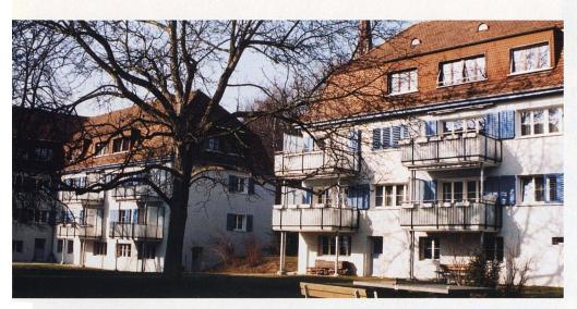
Denkmalpflegerisch gelungene Lösung bei den neuen Balkonen der Siedlung Geibel in Zürich-Wipkingen (Baugenossenschaft Waidberg): In einer statischen Mischkonstruktion sind sie an den Häusern aufgehängt und zusätzlich mit schlanken Pfeilern abgestützt
