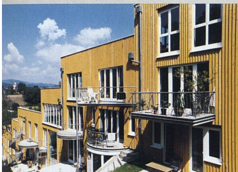
Die Reihenhauseinheiten der Siedlung Gugl Mugl erstrecken sich über sieben Ebenen.
