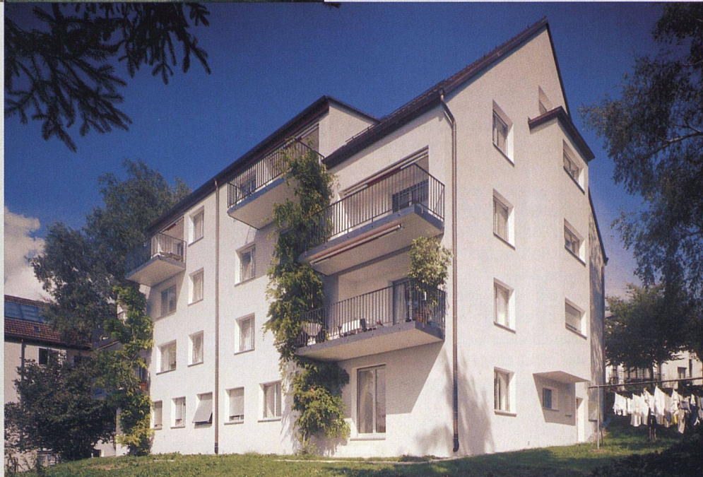
Nach Fertigstellung der ersten Sanierungsetappe im August 2002 sind die Grundzüge der ursprünglichen architektonischen Absicht wieder spürbar.
