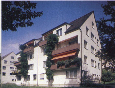
In den 70er-Jahren wurde die Überbauung im Bereich der Gebäudehülle saniert und dadurch optisch stark verändert.
