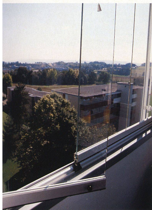
Dank Faltechnik lässt sich die Balkonverglasung mühelos öffnen und schliessen.
