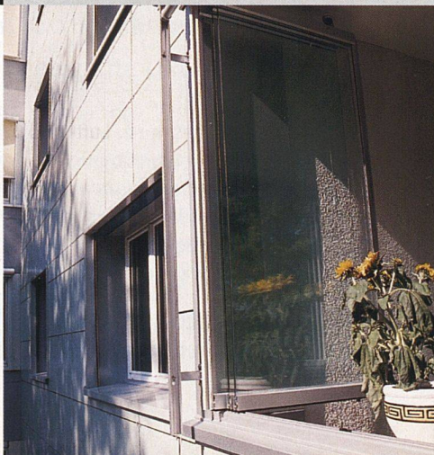
Dank Faltechnik lässt sich die Balkonverglasung mühelos öffnen und schliessen.
